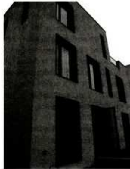
Bild 2: So schaut's aus von außen. Kein Kommentar zur Architektur!
