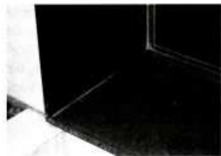
Bild 4: Das Wasser sucht sich schon seinen Weg, oder: Die Kittspritze wird's schon richten!
